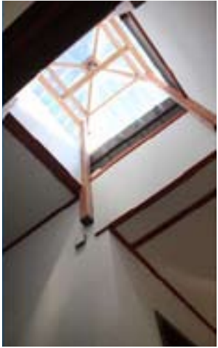
VISTA DE LA NUEVA CÚPULA
